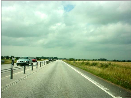
Väg 100 med riktningskiljande mittbarriär av ställinor. Foto: Erik Sjöberg
