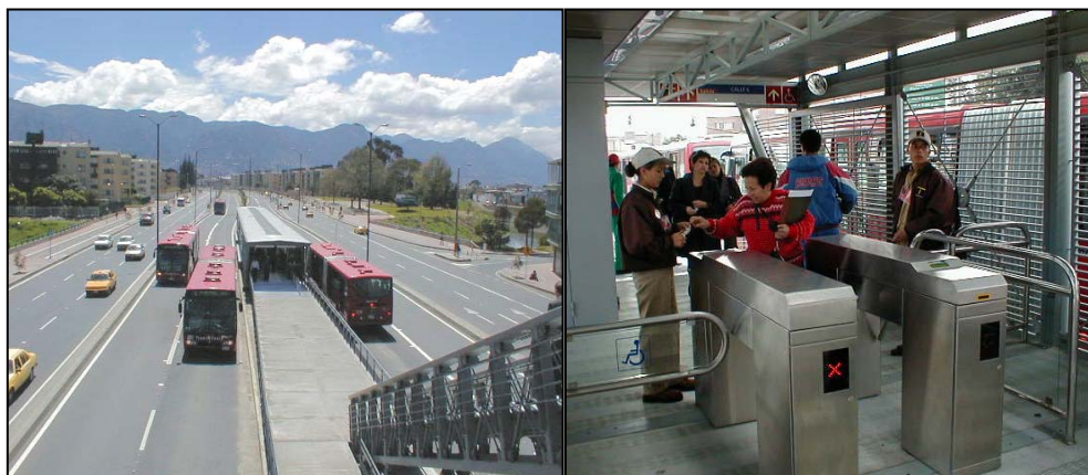
Figur 3.1 Till vänster: en hållplats för det avancerade bussystemet TransMilenio i Bogota. Till höger: en spärr där biljetten makuleras innan man kommer in till hållplatsens ”plattform”.
