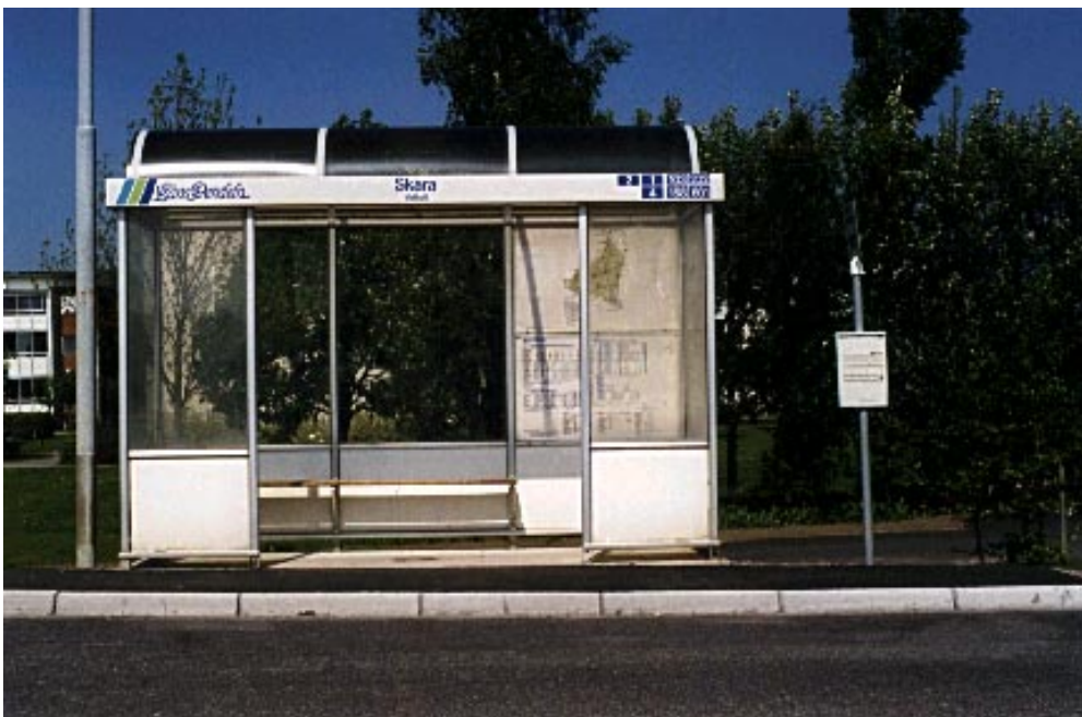
Bild 4:1 Vädskyddens golv, hållplatsens yttre yta och körfältet är utförda i kontrasterande kulörer. Det ökar läsbarheten för synskadade resenärer. Valhall, Skara.
