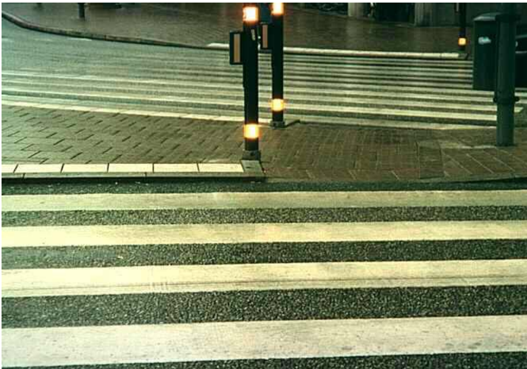
Bild 5:14 Fasad kantsten vid övergångsställe, Stockholm.
