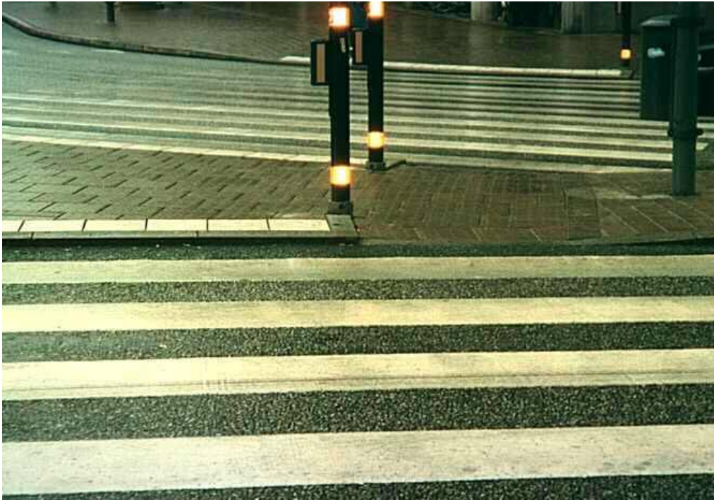
Bild 5:18 Fasad kantsten vid övergångsställe, Stockholm.
