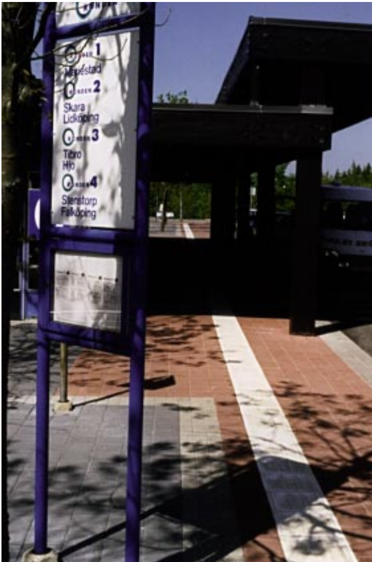
Bild 4:9 Entrépartiets skärmtak når ut över angöringsytan. Ett förhöjt tillägg kragar ut över körytan, vilket lägger på- och avstigningen i sin helhet väderskyddad under tak. Kämsjukhuset, Skövde.
