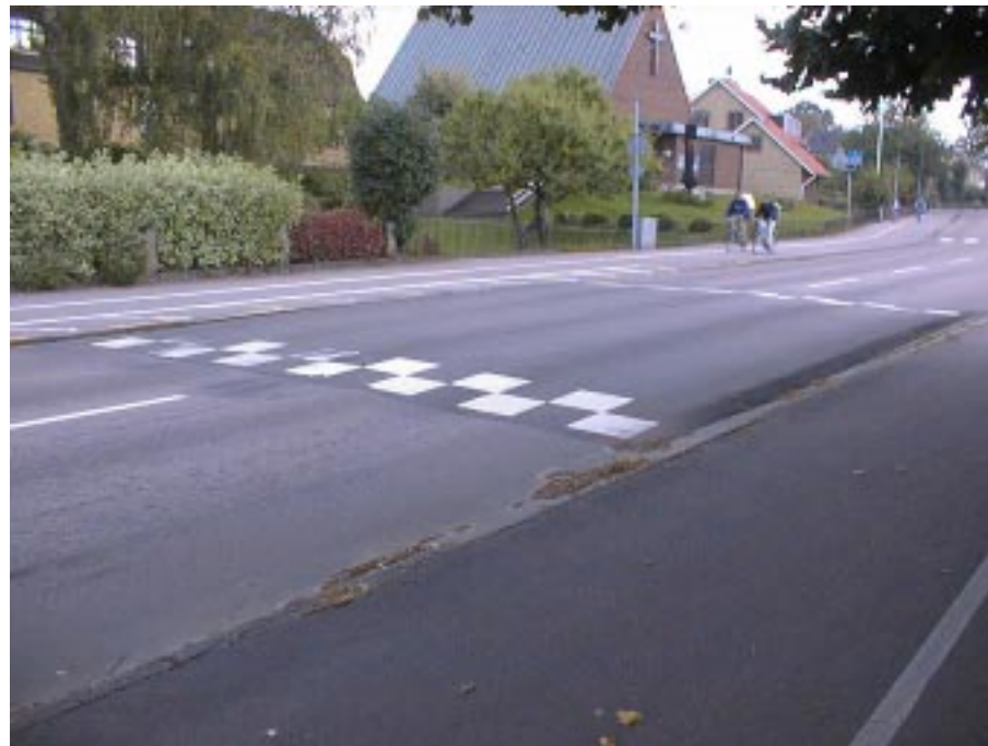
Ett gupp i Kronobergstrafiken som är utformat efter bussarnas konstruktion
