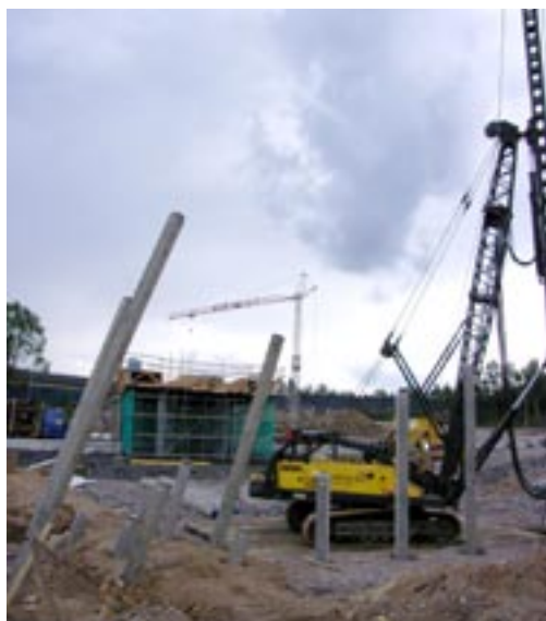
För att marken ska klara att bära både väg och bro slår vi ner pålar i marken med en pålmaskin. Maskinen är högre än vad som syns på bilden.
