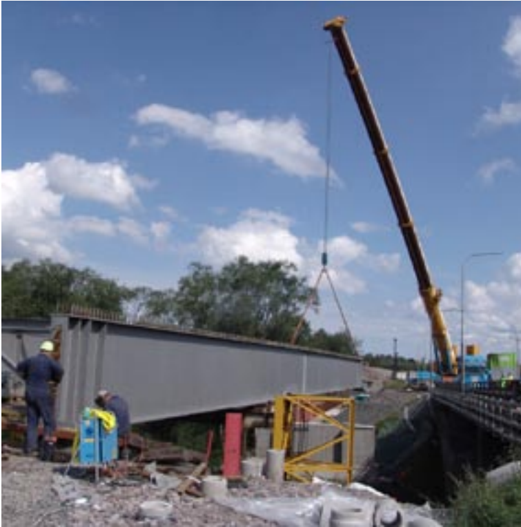
Bron över Tabergsåån lyfts på plats av Sveriges största lyftkran på hjul. Stålbalkarna väger 70 ton. Det tog en hel dag att få bron på plats.
