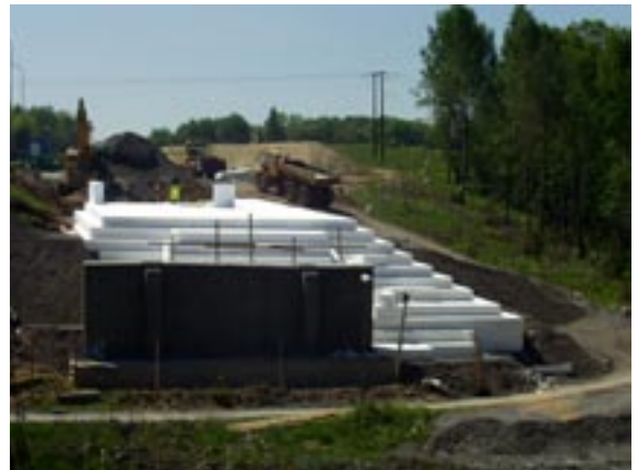
Marken runt bron över Tabergsån är delvis byggd av cellplast! Cellplast är ett lätt material som samtidigt kan bära stor tyngd.
