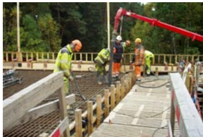
Här gjuter vi en bro av betong. Det killarna står på är armeringen, som håller ihop betongen.
