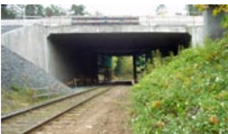
Nya bron över järnvägen (Vaggerydsbanan). Två körfält används redan, resten håller på att byggas.
