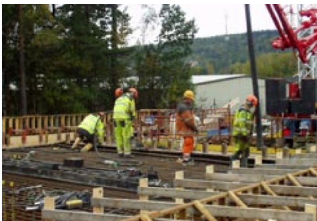
Här på nya järnvägsbron jobbar både snickare, armerare och betongarbetare.
