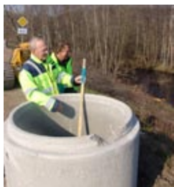
Mätning av rörelser i marken intill Tabergsåån.
