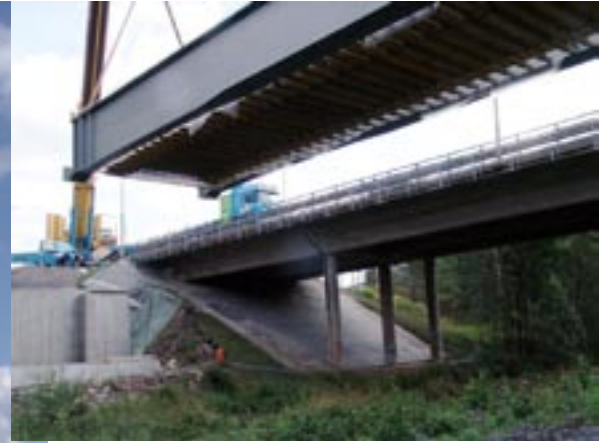
Bron över Tabergsåån lyfts på plats av Sveriges största lyftkran på hjul. Stålbalkarna väger 70 ton. Det tog en hel dag att få bron på plats.
