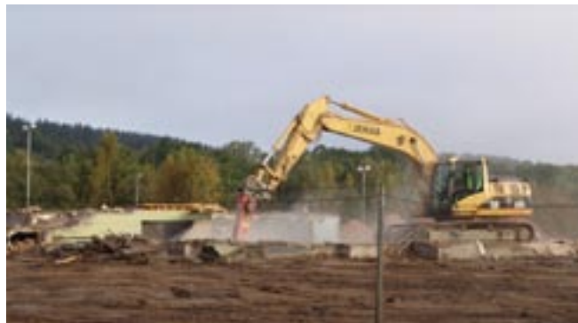
Innan vi började bygga väg 40 fick vi riva några gamla industribyggnader.
