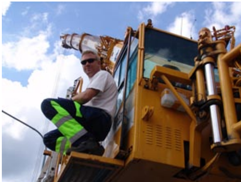
Den här kranföraren sköter Sveriges största lyftkran på hjul. Här har han just lyft bron över Tabergsån på plats.
