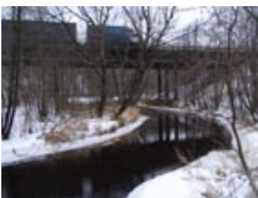
Naturen runt Tabergsån är känslig. Därför är det viktigt att vi är noga när vi bygger så att inga farliga ämnen rinner ut i vattnet.
