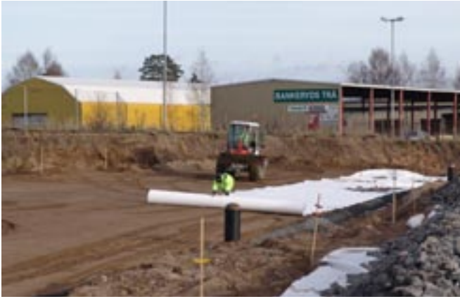
Här lägger vi ute en fiberduk för att de olika materialen, sand och krossat berg, inte ska blandas med varandra.
