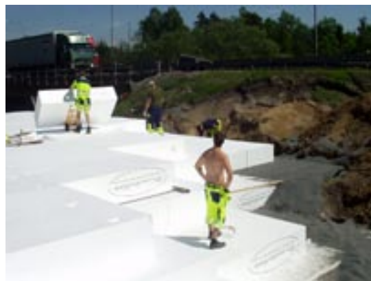
Dellplasten som förstärker marken intill bron.
