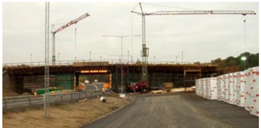
Här bygger vi bron som ska ta Gräshagsgatan över väg 40.
