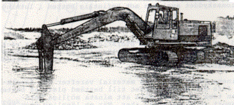
Fig 6 a-c. Olika moment vid utläggning av erosionskydd med grävmaskin.
