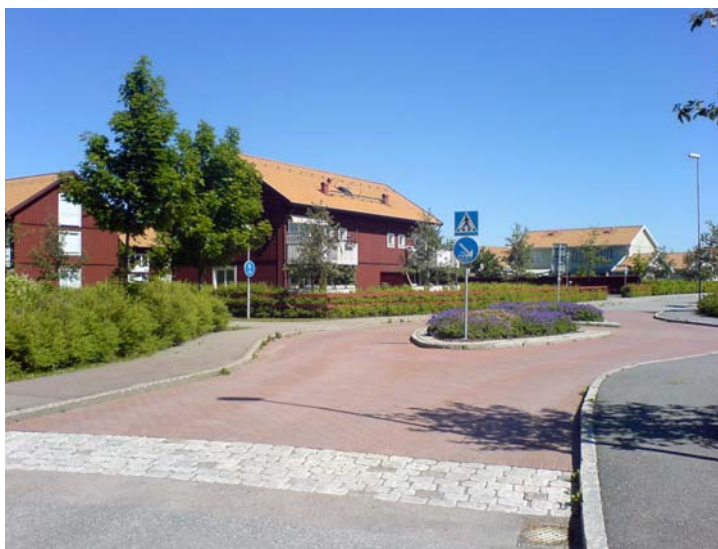
Diagram 25. Upphöjd korsning med sidoförskjutning och beläggning i avvikande färg och textur.
