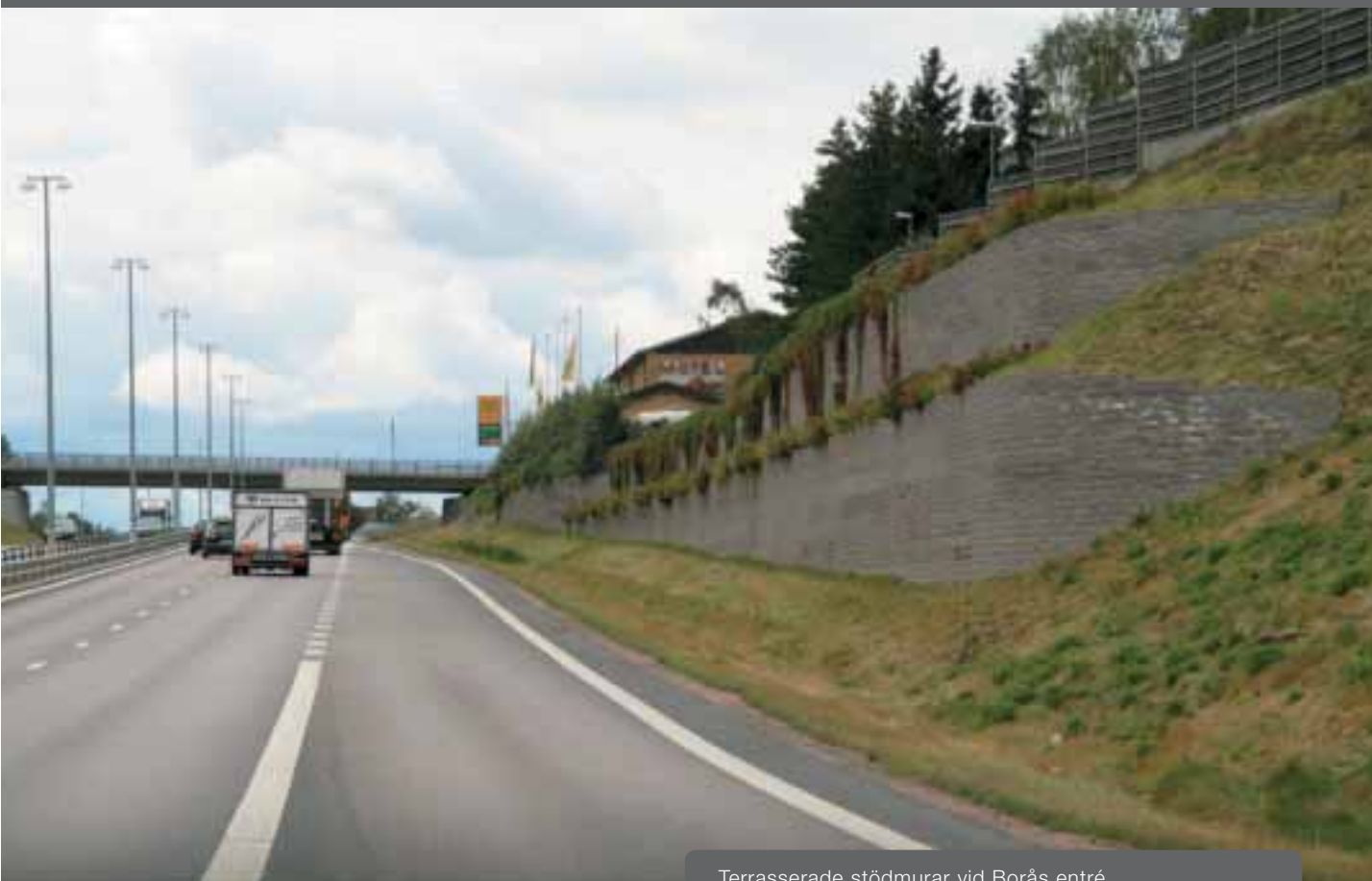
Terrasserade stödmurar vid Borås entré.
