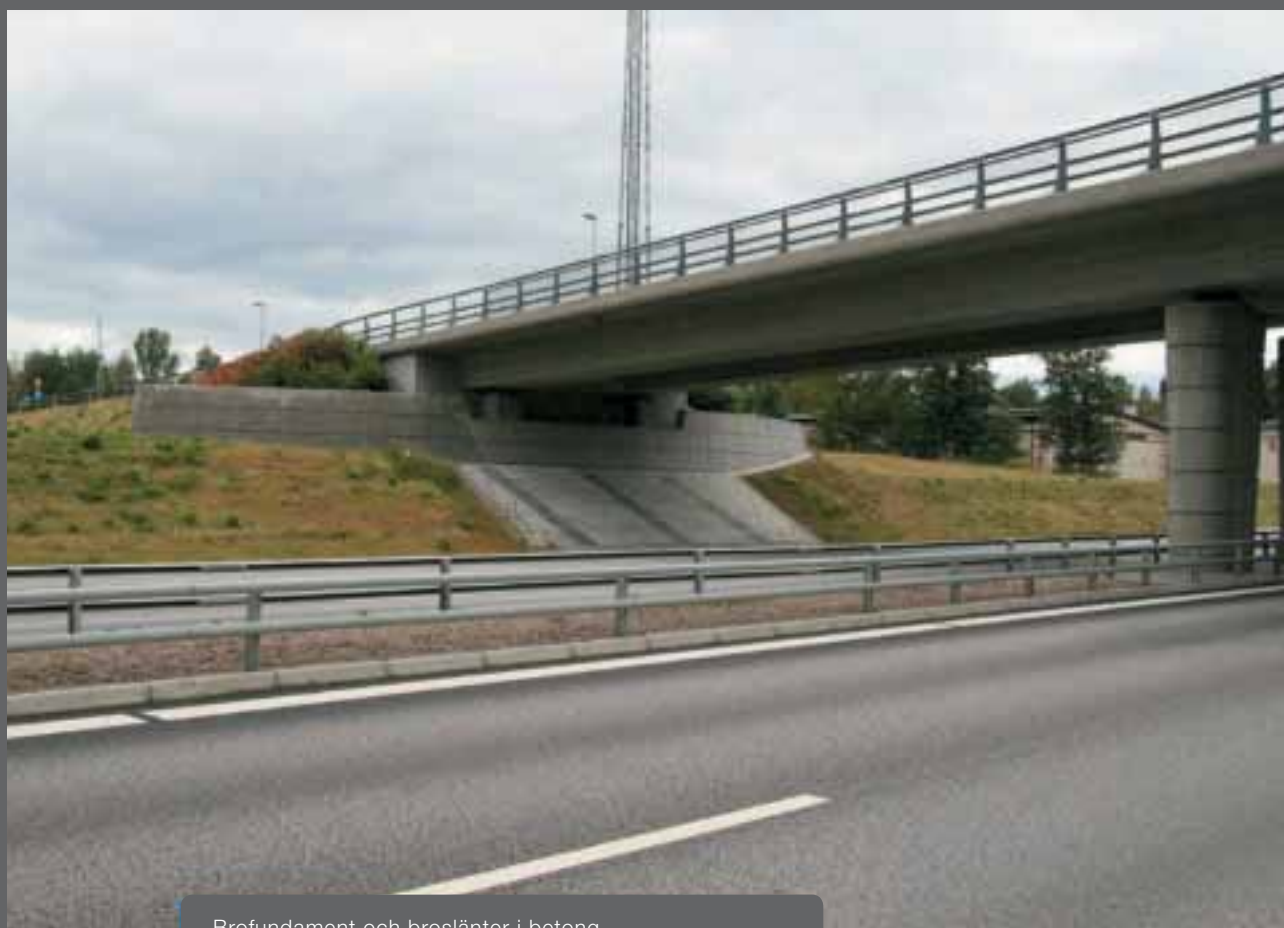
Brofundament och broslänker i betong.
