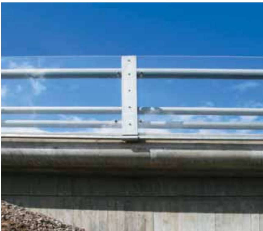
Bröräcke, bullerskydd och vackra betongytor, Rångedalabron.
