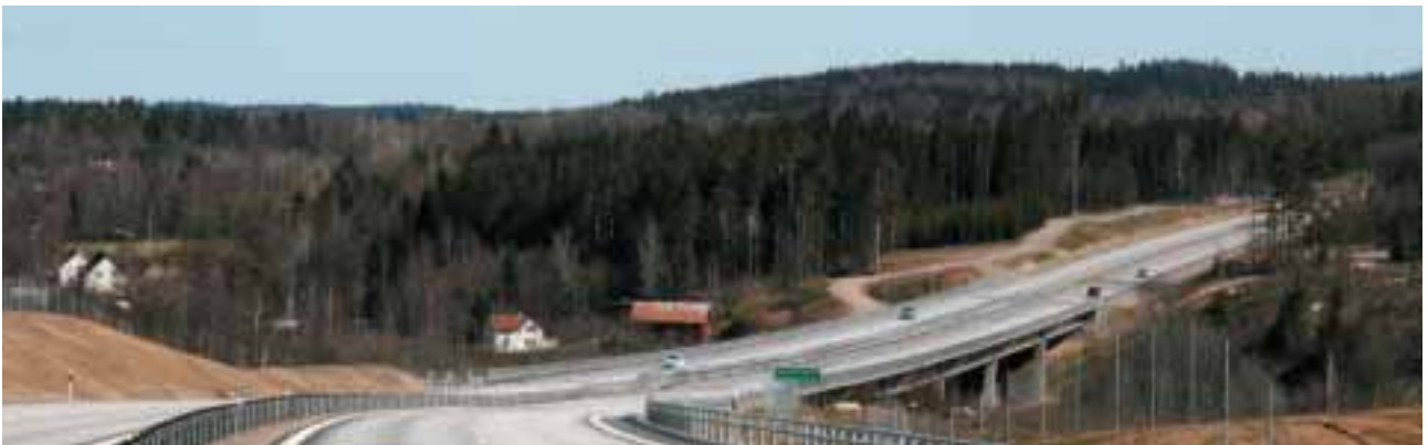
Vägens möte med Rångedala-bron upplevs som om bron "svankar". Detta är en konsekvens av att väglinjen korsar en bred dalgång och ambitionen att minska den totala brolängden.
